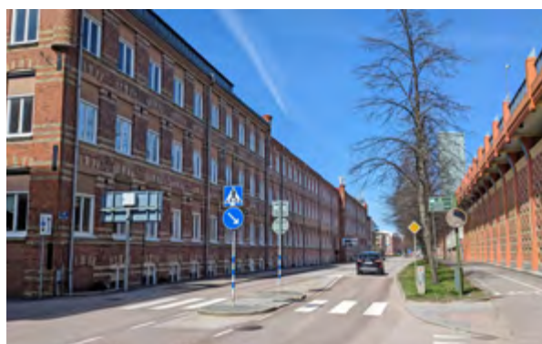
Vy av Fabriksgratan med en jämnare bebyggelse volymer. Bild Ashwin Karjatkar
